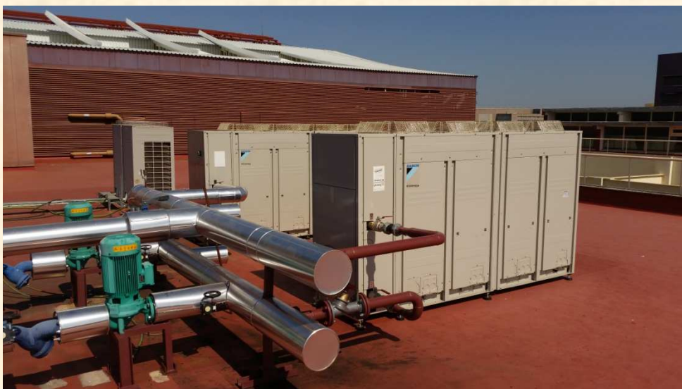
Grupo de enfriadoras Daikin de una vertical en proceso de ejecución.
